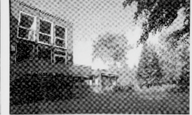
Auf diesem angrenzenden Gelände neben dem Flachdachgebäude soll der Erweiterungsbau entstehen.
